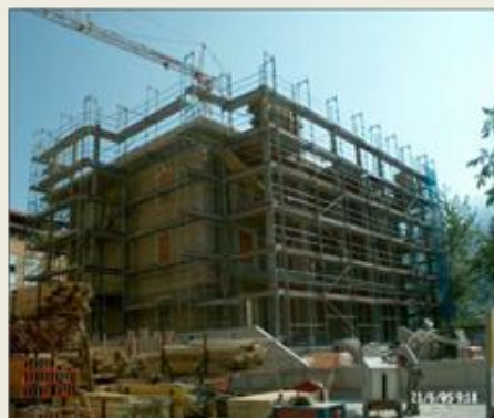
Impianto di cantiere
