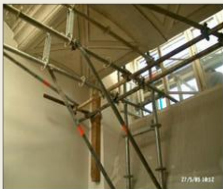
Stabilizzazione della struttura
