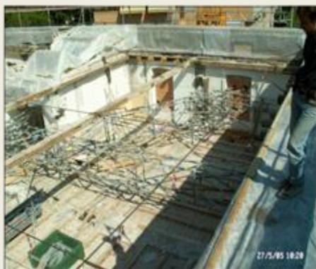
Stabilizzazione della struttura
