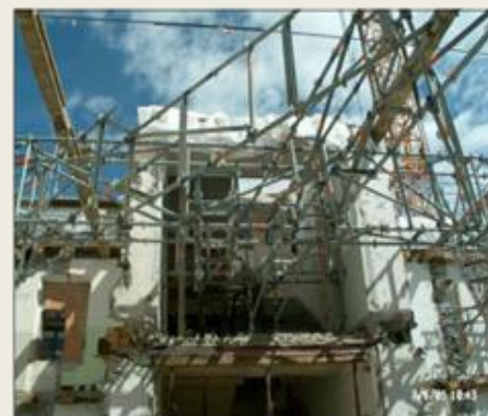
Stabilizzazione della struttura
