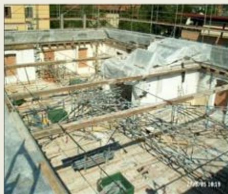
Stabilizzazione della struttura
